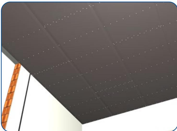
**6.** Procedere con la posa dei pannelli di STIFERITE RP posandoli, se possibile, ortogonalmente all'orditura dei traversi. Fissare i pannelli con viti fosfatate auto-filettanti con testa piana e svasata di lunghezza pari a 25mm più lo spessore dello strato isolante
