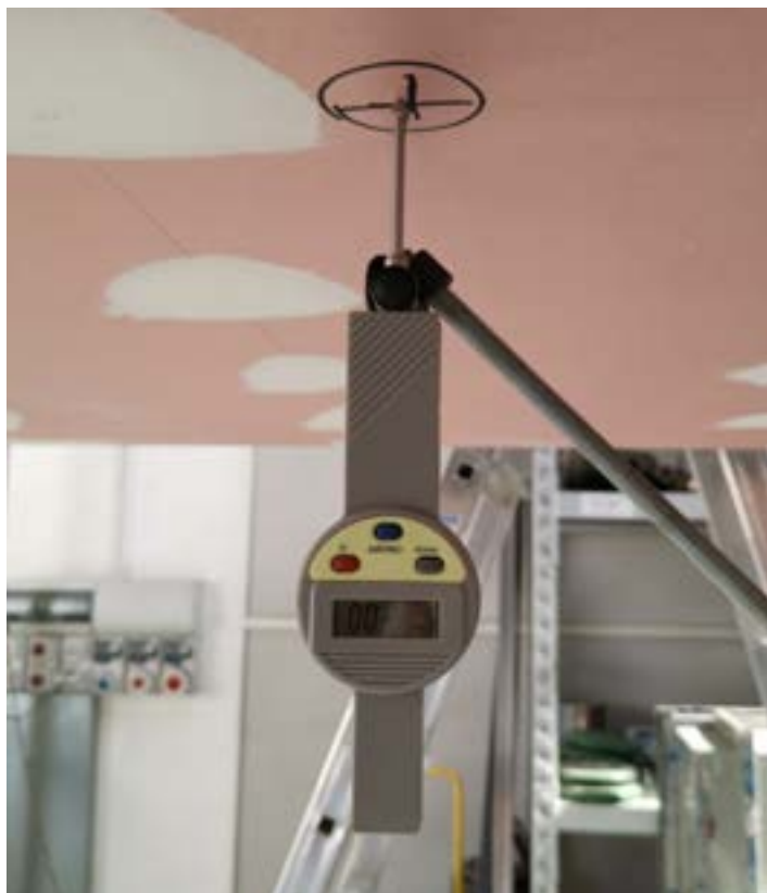
Strumento di misura delle deformazioni
