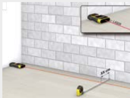
1. Tracciamento guida a pavimento
