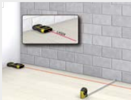
2. Tracciamento del limite esterno della controparete
