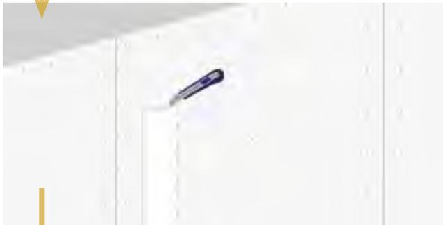
Eeguire il taglio della/e lastre mediante l'utilizzo di un cutter, aumentando la larghezza del foro di ca. 2/3 mm di spessore rispetto al filo sagoma. Nel caso di doppia lastra conservarne un pezzo.
