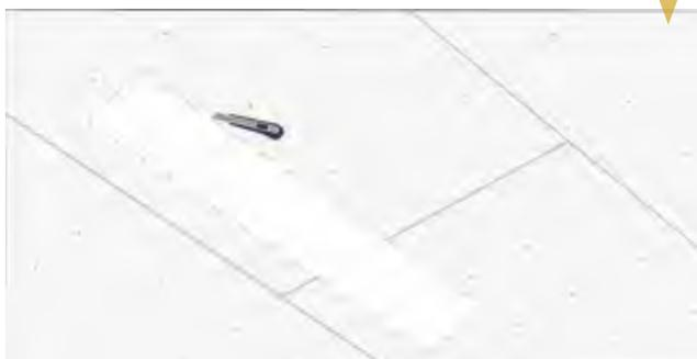
Eeguire il taglio della/e lastre mediante l'utilizzo di un cutter, aumentando la larghezza del foro di ca. 2/3 mm di spessore rispetto al filo sagoma. Nel caso di doppia lastra conservarne un pezzo. Si dovrà prestare attenzione ai profili sottostanti.
